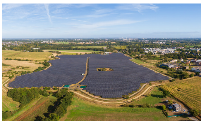
Parc photovoltaïque de Bruz-Pont-Péan (35)
